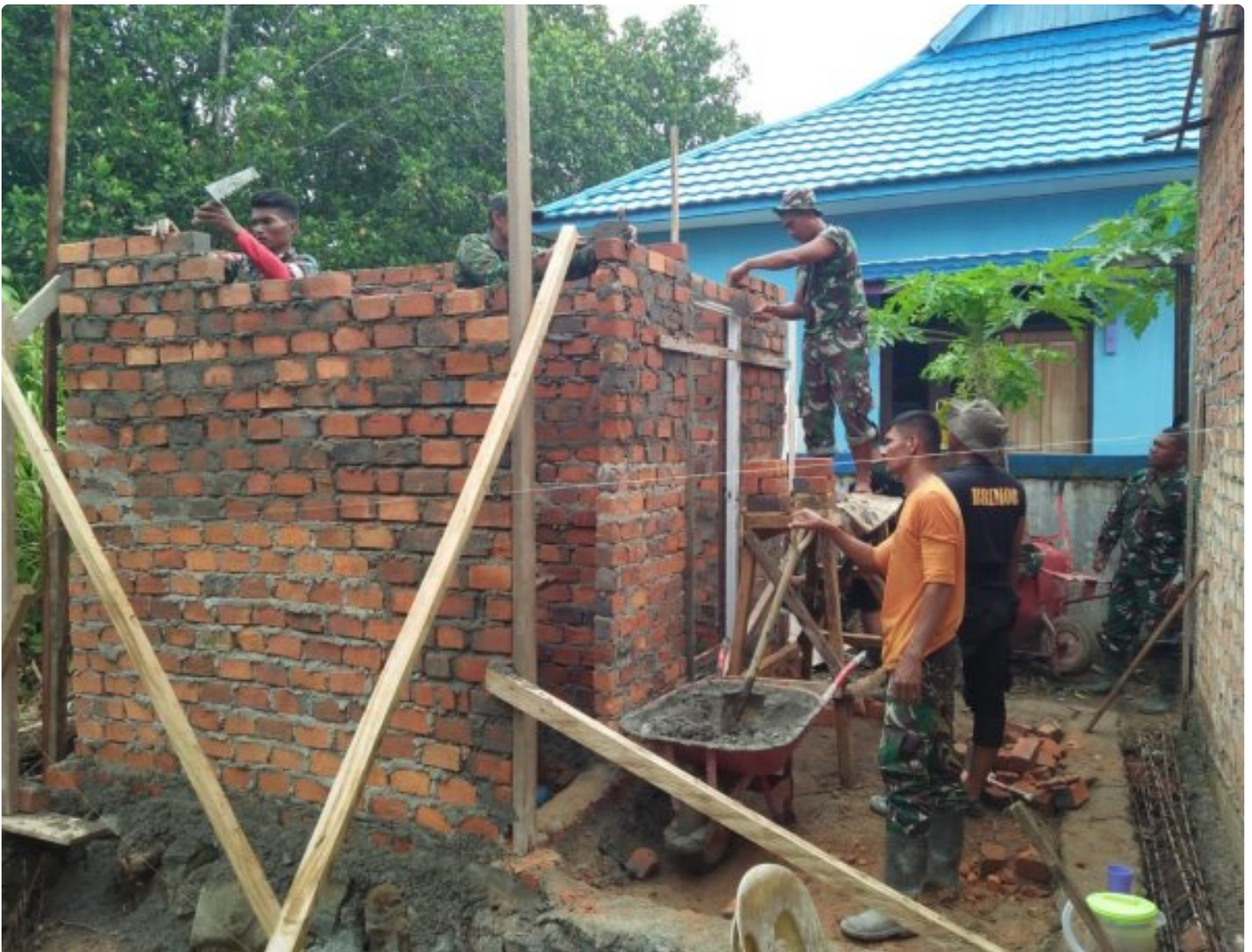
Pasiter Tinjau Proses Pekerjaan Sasaran Tambahan TMMMD ke-118 Pembangunan MCK Gereja
