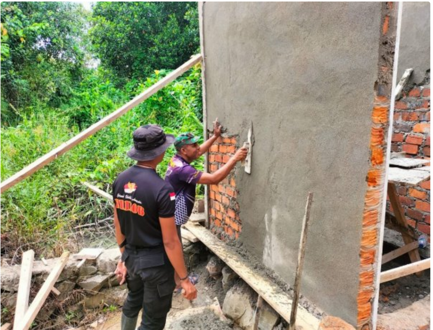
Satgas TMMMD Ke- 118 Wiltas Kodim 0910/Malinau Plester Dinding Pembangunan MCK Gereja
